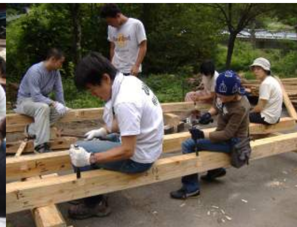
在来工法による大工実習
